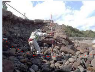
⑧ 護岸中詰部 崩壊・飛散状況
