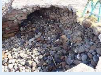
⑧ 護岸中詰部 崩壊・飛散状況
