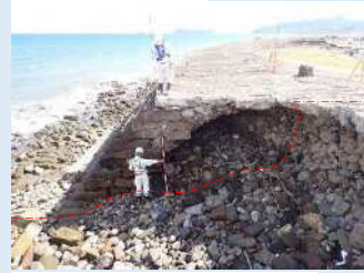
⑨ 護岸階段部 崩壊・飛散状況
