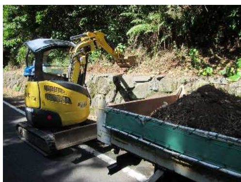
崩土の撤去状況
