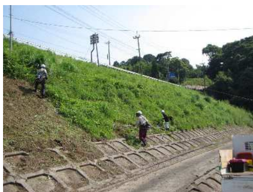
法面の除草状況
