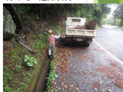
側溝清掃状況
