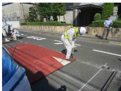
舗装の削孔
