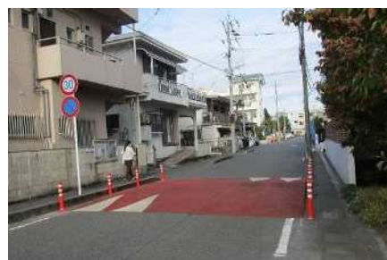
ハンプ設置の実証実験(R4.10) ※郡元3丁目地区
