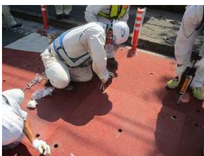
アンカーボルト設置
